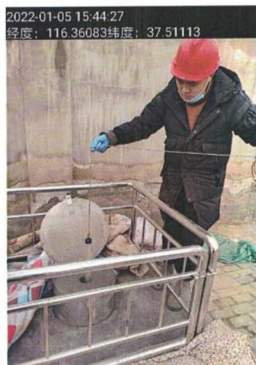
DZDXS010015 德州实华 2#地下水监测井
