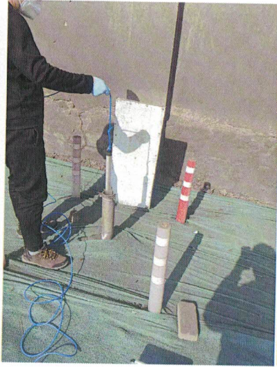
DZDXS010015 德州实华 2#地下水监测井
