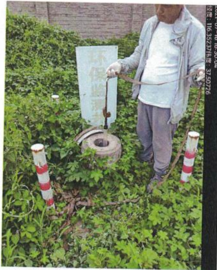
DZDXS010014 德州实华 1#地下水监测井
