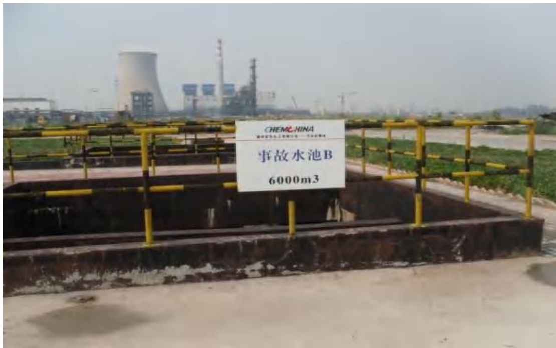
厂区事故水池
