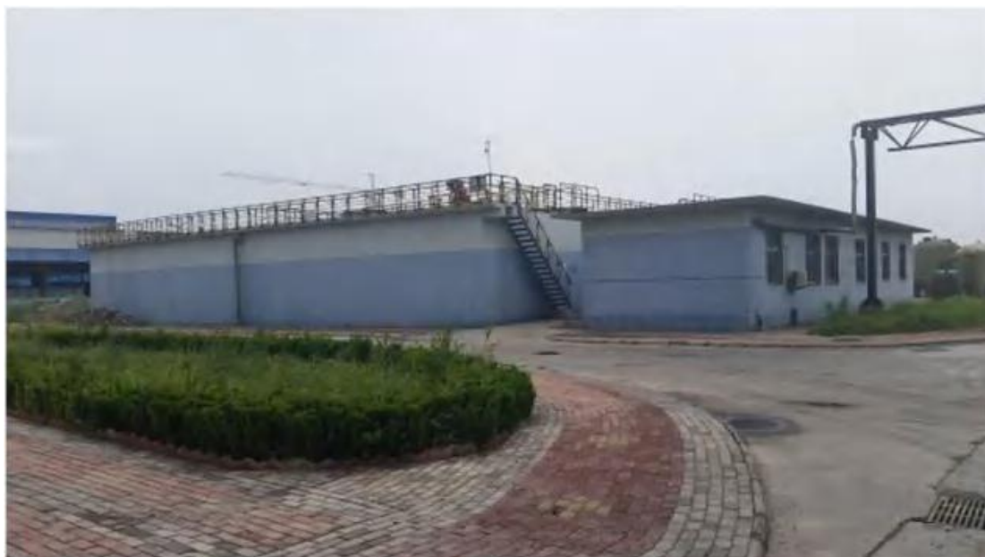
厂区综合污水处理站
