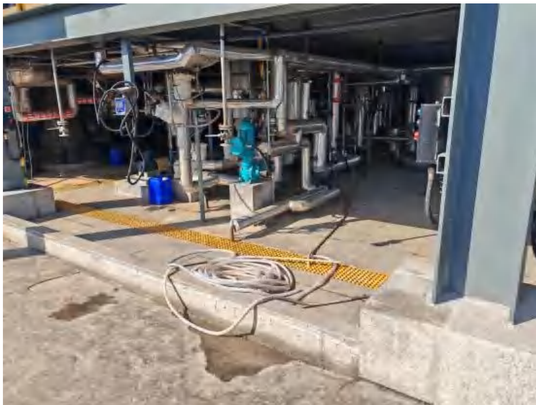
装置区围堰、地沟
