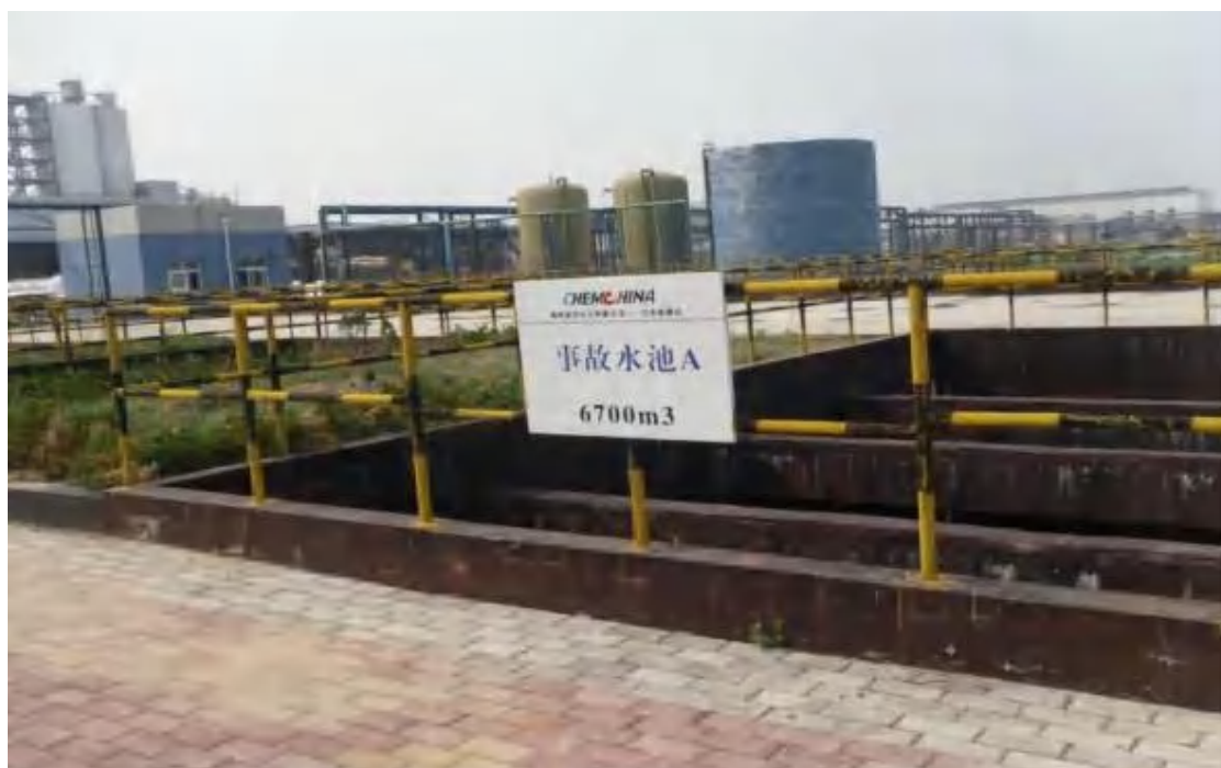
装置外东北角废水收集池
