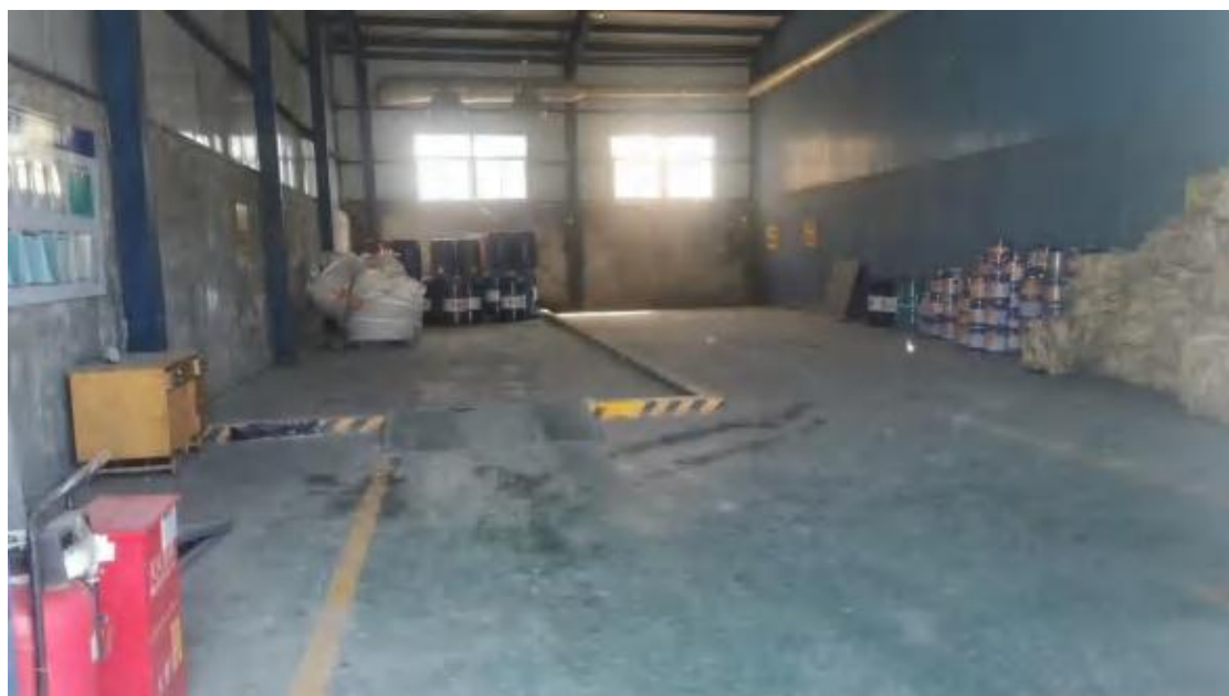
项目危废暂存间
